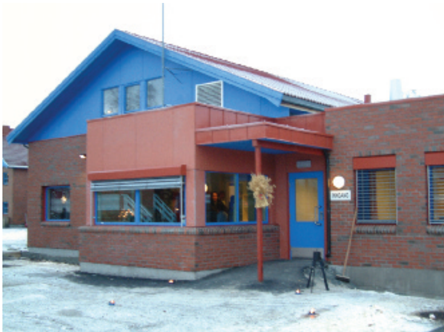
Det nye vaktbygget ved inngangen til fengselsområdet.
